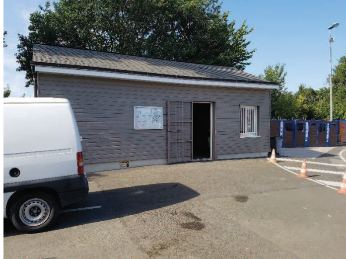
Photo n°1 : Local des agents présent sur la déchèterie de Craon
